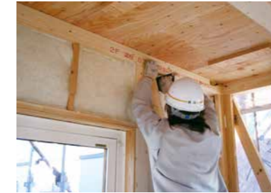
② 適切な長さでカットし、タッカーで止めます
