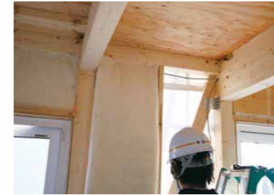
① 柱間に合った中の羊毛断熱材を選び、柱間に入れます
