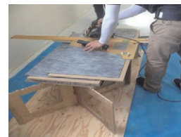
④ 納め代部分のカット 丸ノコにて切断
