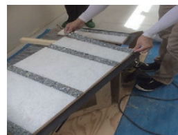
⑥ ウレタン緩衝脚の取付 補充用ウレタン緩衝脚取付
